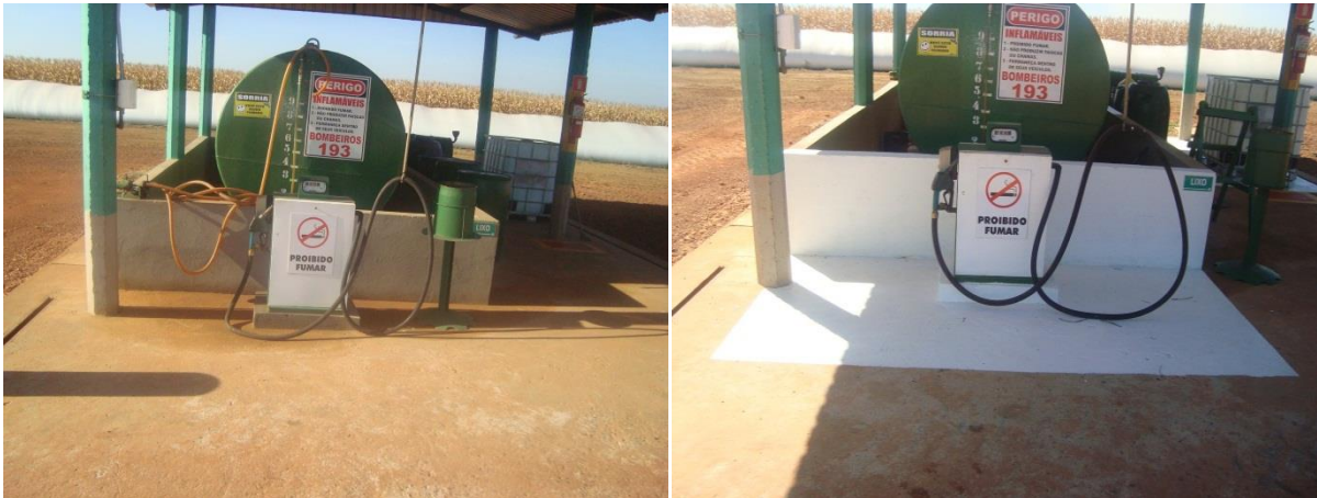
Figura 6 – Antes e depois do local de abastecimento
